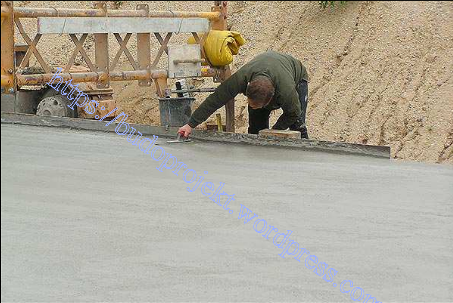
Proces 'układania' nawierzchni betonowej.
