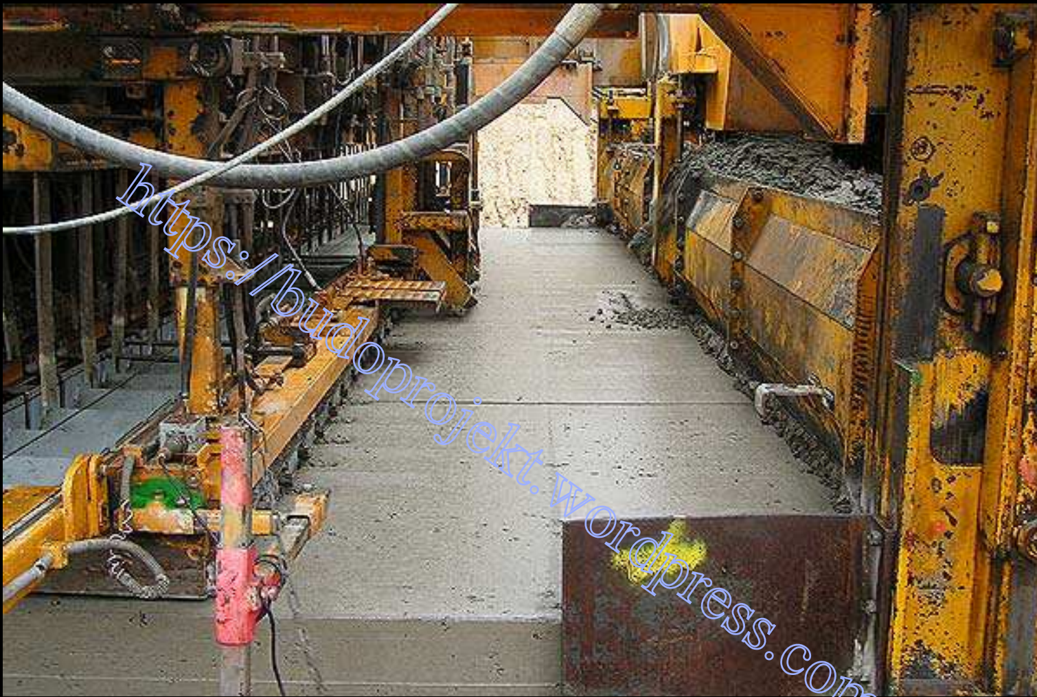
Proces 'układania' nawierzchni betonowej.
