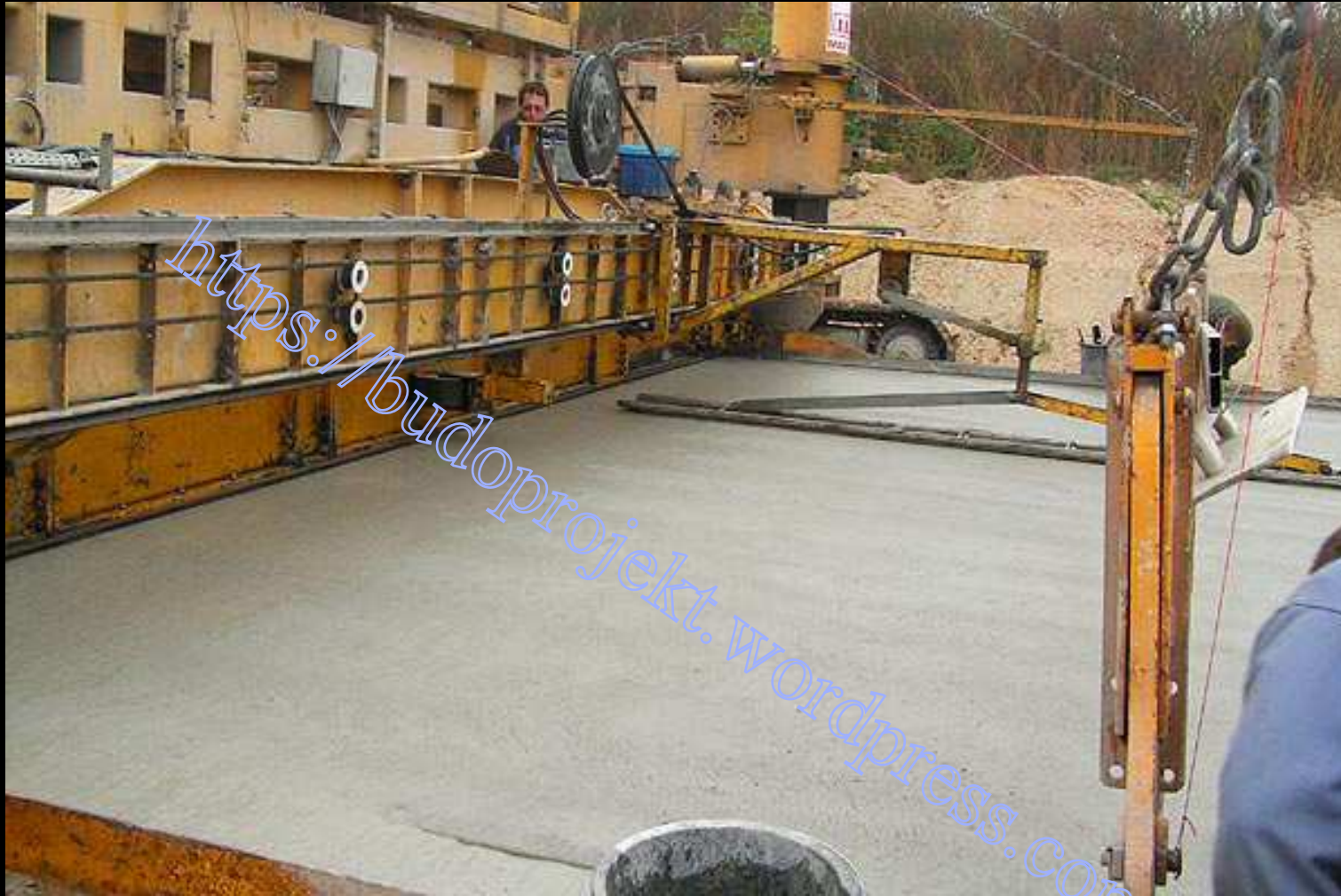
Proces 'układania' nawierzchni betonowej.
